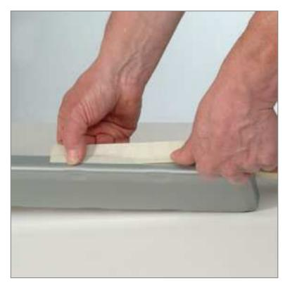
Poncer la partie extérieure du Douche Drain pour renforcer l'adhérence avec le mortier.
